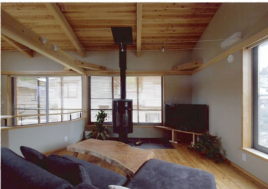
2階 遠山杉のフローリング。足にやさしい感触の杉材 (写真は唐松のフローリング)
