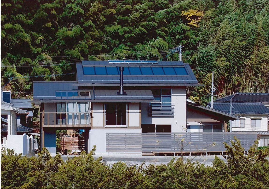
OMソーラーのガラスパネルがのった、ガルバリウム鋼板葺きの屋根
