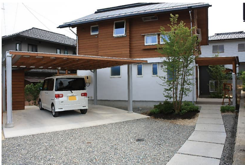
信州唐松の外壁（唐松は縦張りりと横張りがあります） （写真は白州そとん壁）
